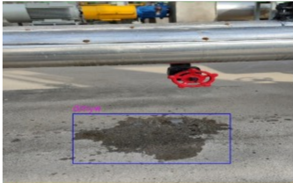
平らなセメント路面での漏れ検出
